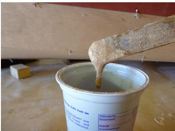
Die Klebestelle wird dünn mit dem angedickten Epoxy bestrichen. Damit die Leisten nicht aneinander abgleiten, bekommt die Klebestelle auf beiden Seiten eine Tackerklammer. Damit ich die Klammer später besser herausziehen kann, klammere ich durch etwas Baufolie hindurch...
